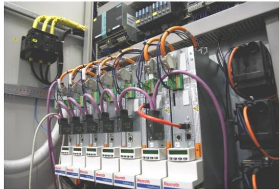
Servoachsen des Handlings mit Bosch-Rexroth Antriebssystem
